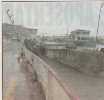
Reparo do atracadouro deve levar, no mínimo, 90 dias
